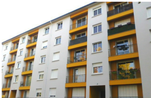
Fougères - Rue de la Pinterie - 2015
