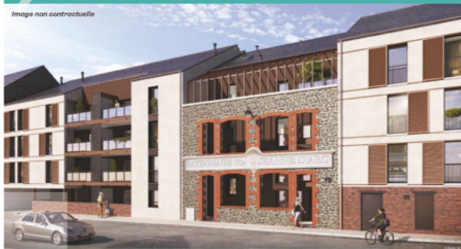
Dans le quartier de Bonabry, une nouvelle résidence va voir le jour à la place de l'ancien cinéma.
