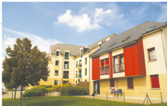
En cours de travaux à la résidence des Urbanistes (133 logements)
